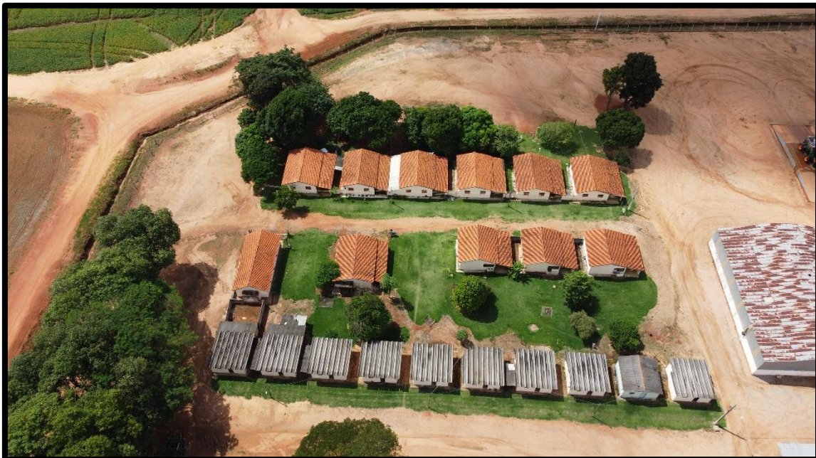
Casas funcionarios drone DJI
